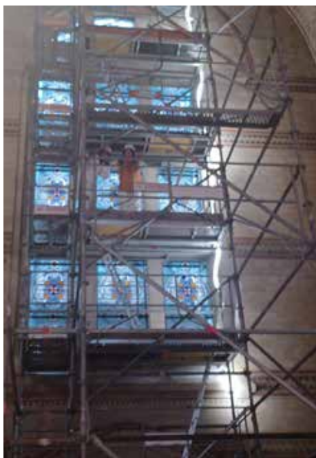
Les derniers échafaudages
